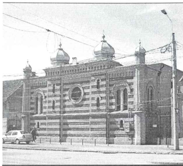
A Fröbel utcai zsinagóga utcai homlokzata
