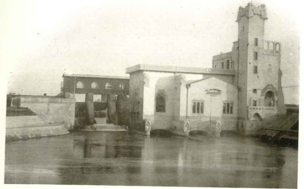
A városi villamostelep vízerőművének külső képe.
